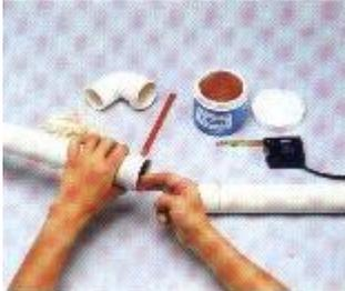
4) Encaixar a ponta chanfrada do tubo no fundo da bolsa, recuar 5mm no caso de canalizações expostas e 2mm para canalizações embutidas, tendo como referência a marca previamente feita na ponta do tubo. Essa folga se faz necessária para a dilatação da junta.
