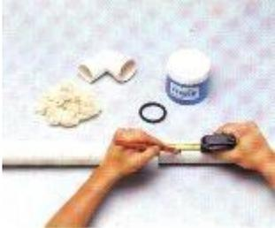
2) Colocar o anel de borracha na virola da bolsa, do tubo ou da conexão.
