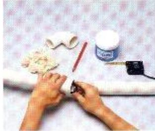
3) Aplicar a pasta lubrificante no anel e na ponta do tubo ou conexão. Não usar óleo ou graxa, que poderão prejudicar o anel de borracha.
