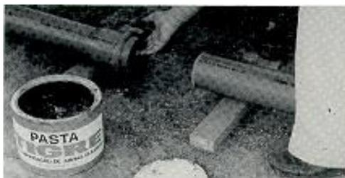
Figura 58: Aplicação da pasta lubrificante
