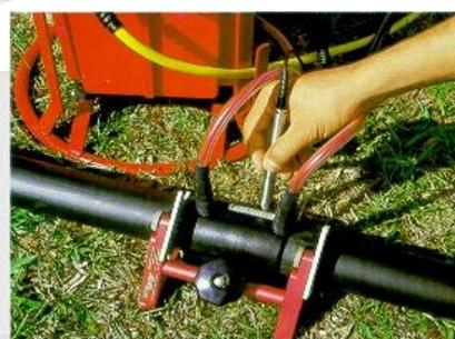
Figura 98: Encaixe da luva, observando a marcação efetuada
