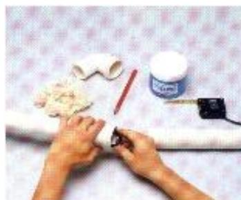
**Figura 179: Colocação do anel de borracha**
