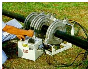
**Figura 77: verificação da pressão de solda**
