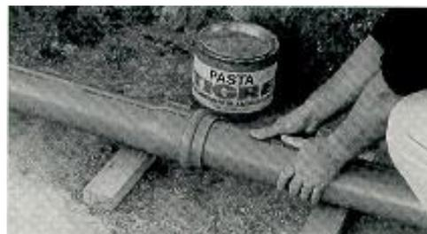
Figura 59: Introdução da ponta chanfrada do tubo até o fundo da bolsa
