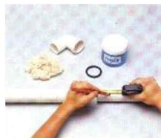
**Figura 178: Marcação da profundidade da bolsa na ponta do tubo**
