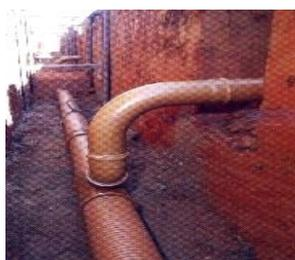
**Figura 182: PVC linha esgoto sanitário**
