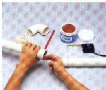
**Figura 180: Aplicação da pasta lubrificante**
