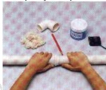
**Figura 181: Encaixe da ponta chanfrada do tubo no fundo da bolsa**
