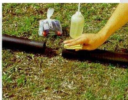
Figura 97: Limpeza com solução à base de acetona
