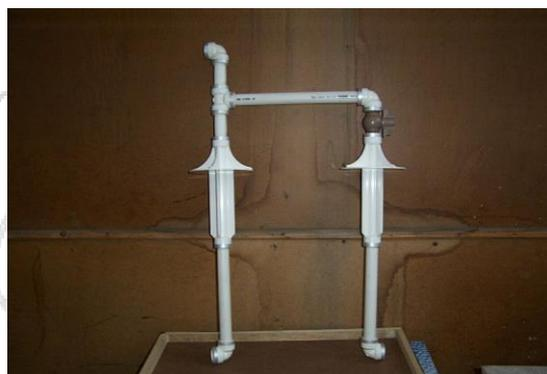
**Figura 170: Cavalete de PVC do tipo pontas roscáveis**
