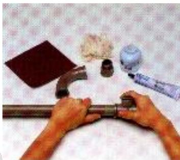
**Figura 153: Encaixe das partes a serem soldadas**
