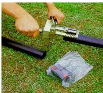
Figura 96: Raspagem da área de contato com raspador mecânico ou manual
