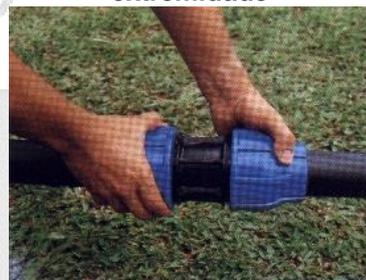
Figura 147: Encaixe do tubo na bolsa da conexão
