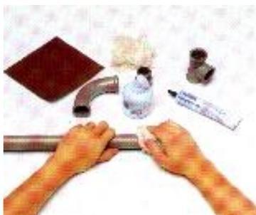
Figura 151: Limpeza das superfícies lixadas
